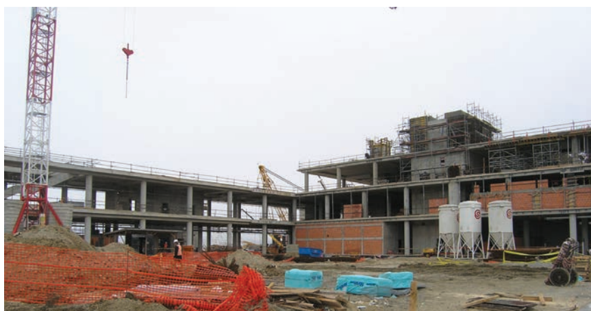
Armiranobetonski radovi su uglavnom završeni
