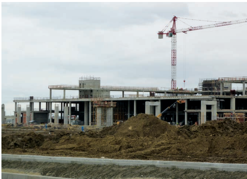
Detalj gradilišta tijekom posjeta
