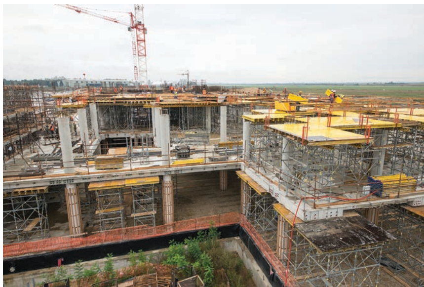
Radovi su već dobro uznapredovali
