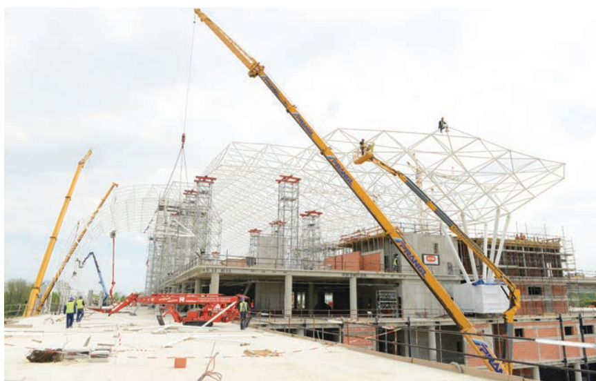
Naziru se obrisi čelične konstrukcije
