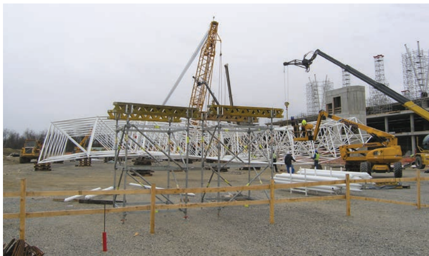
Početak radova na čeličnj konstrukciji
