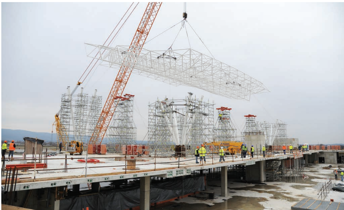
Nedavno snimljen detalj montaže čelične konstrukcije
