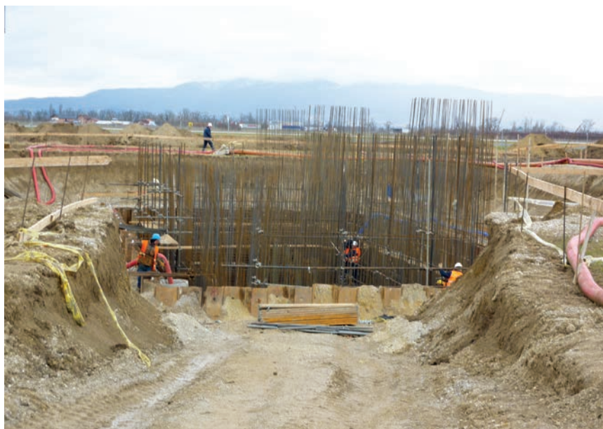
Gradnja spremnika za vodu
