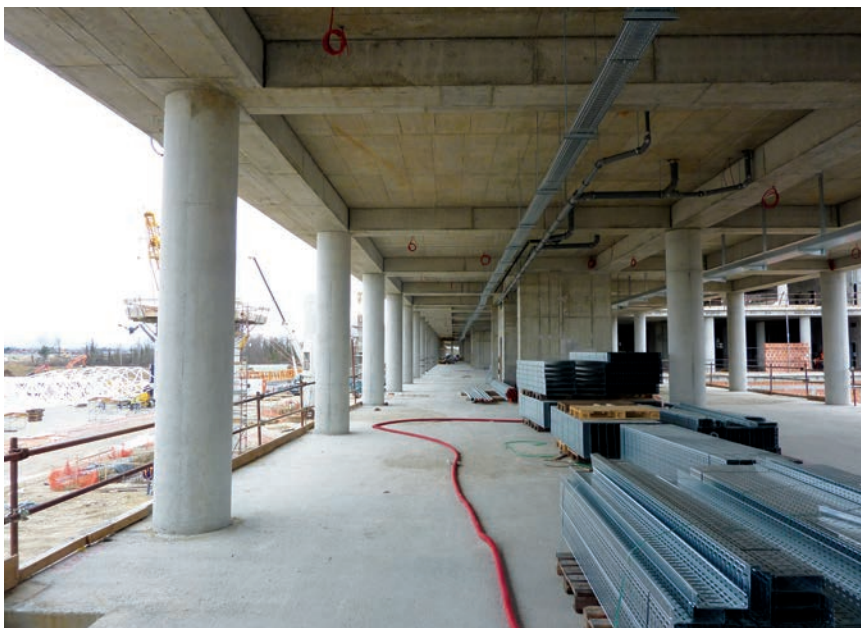
Armiranobetonski stupovi u prizemlju zgrade
